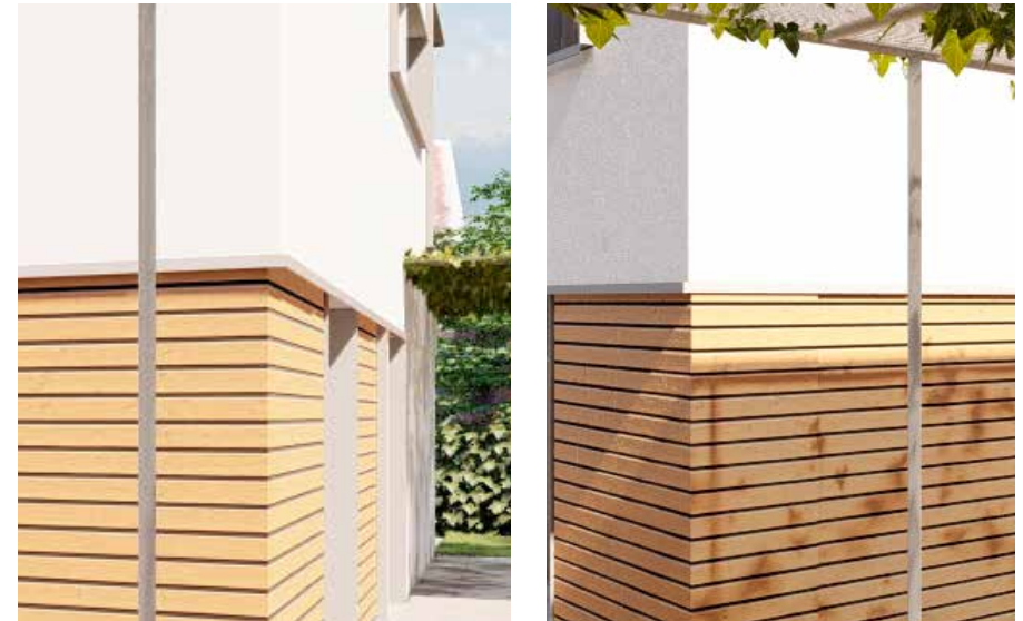
Revestimiento S.A.T.E. y madera composite o similar
