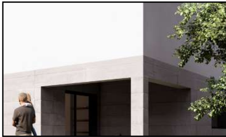
Revestimiento monocapa y piedra
